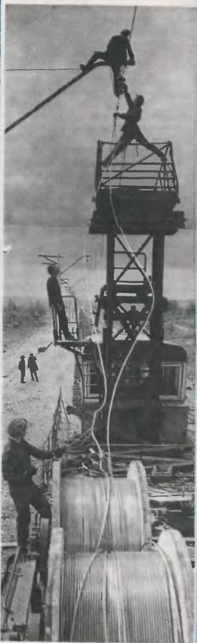
Идет прокладка контактного провода. Фотохроника ТАСС.
